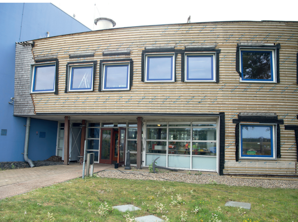
De ronde vormen van het oude RWS-kantoor zijn terug te zien bij de nieuwe kliniek, logischerwijs vanwege het hergebruik van de gevelstenen.
